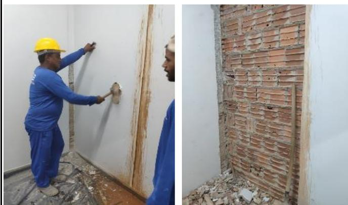
Figuras 05 e 06: Abertura de vão na alvenária existente na sala de TI.
