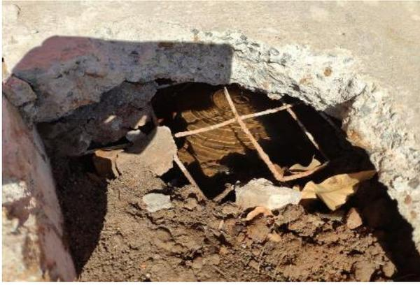
Figura 06: Identificação de vazamento d'agua localizado na calçada em frente ao abrigo de resíduos.
