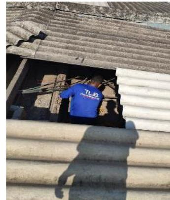
Figura 04: Passagem de fiação elétrica para utilização dos ar condicionados da sala de TI.
