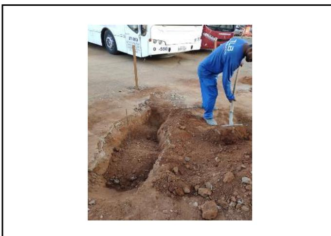
Figura 04: Fechamento de buraco presente no solo após sanar o problema de tubulação danificada.
