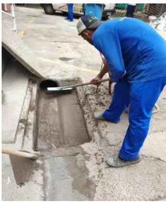
Figura 01: Limpeza na caixa de passagem de esgoto presente na unidade.
