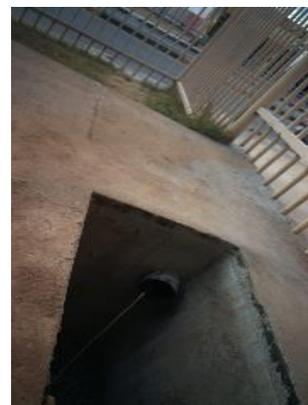
Figura 05: Passagem de guia na tubulação de telefonia para auxiliar na passagem da fiação.
