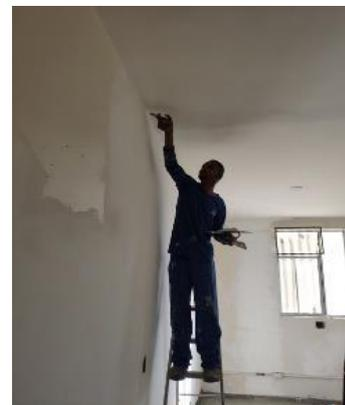
Figura 05: Aplicação de massa pva no teto da sala de CME da unidade.
