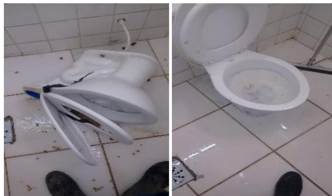
Figuras 05 e 06: Desentupimento do vaso sanitário presente no banheiro masculino do segundo pavimento.
