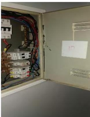
Figura 04: Verificação de curto elétrico no circuito de iluminação da unidade.
