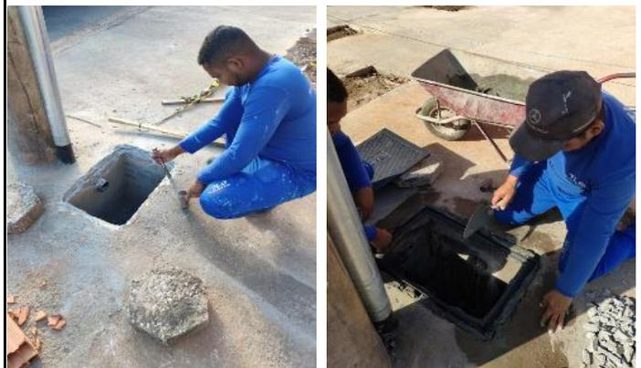
Figura 02 e 03: Troca de caixa externa de telefonia.
