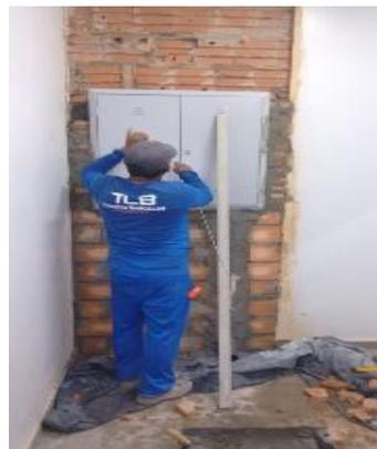
Figura 08: Instalação de quadro de telefonia na sala de TI da unidade.
