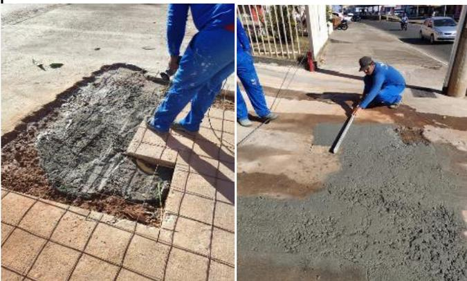
Figuras 01 e 02: Término da concretagem da calçada localizada em frente ao abrigo de resíduos.
