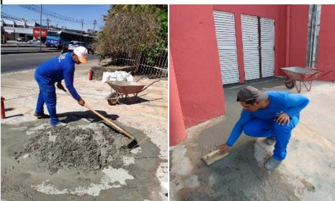
Figuras 04 e 05: Concretagem da calçada localizada em frente ao abrigo de resíduos da unidade.
