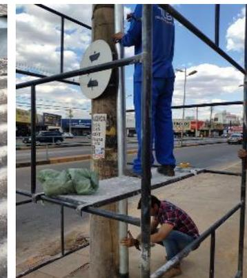
Figura 05 e 06: Execução de reboco na alvenária construída para fixação do quadro de telefonia.
