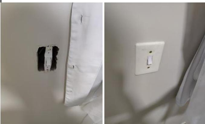
Figuras 01 e 02: Instalação de tampa espelho na sala de coleta.
