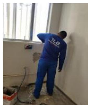
Figura 04: Aplicação de massa pva nas paredes da sala em reforma.
