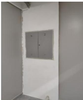
Figura 03: Emassamento com massa pva da parede interna da sala de TI.
