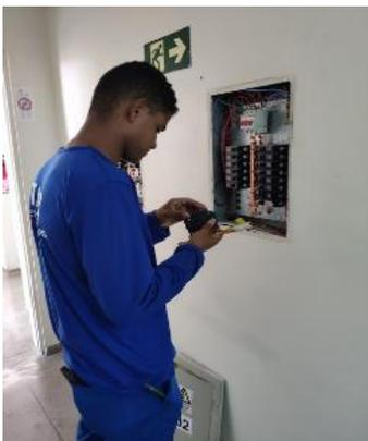
Figura 03: Instalação dos disjuntores para alimentação do ar-condicionados do TI.
