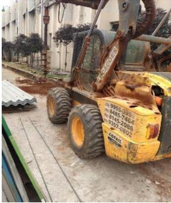
Figura 06: Acompanhamento da perfuração realizada para execução do muro.
