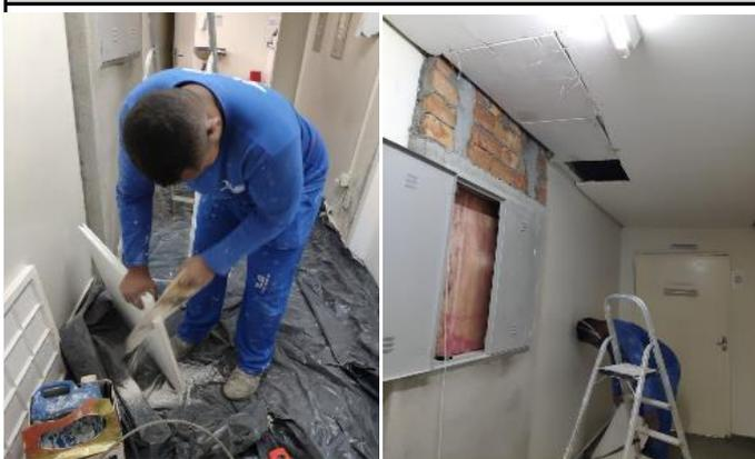
Figuras 01 e 02: Fechamento de abertura presente no teto do segundo pavimento utilizando placas de gesso.
