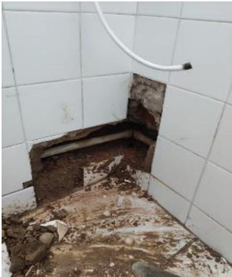
Figura 01: Averiguação e reparo em tubulação que apresentava vazamento d'agua.
