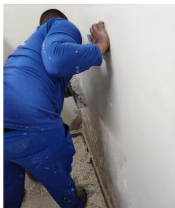
Figura 01: Correção de imperfeições em alvenaria utilizando gesso.
