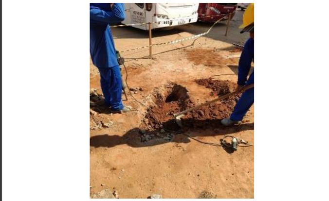
Figura 01: Reparo na tubulação danificada após perfuração do solo.
