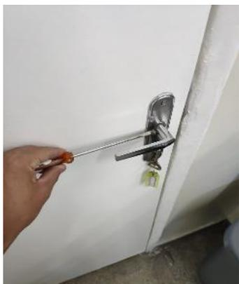
Figura 04: Reparo da maçaneta presente na porta da sala de fracionamento.
