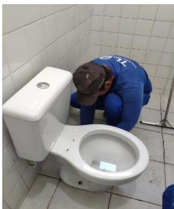
Figura 01: Retirada do vaso sanitário presente no abrigo de resíduos.
