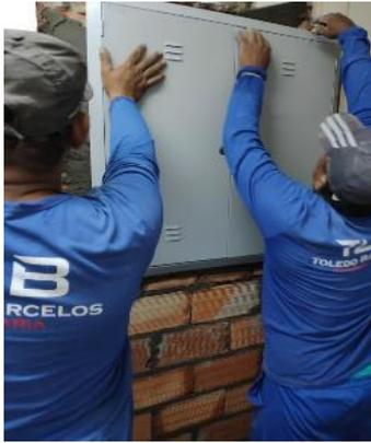
Figura 08: Fixação do novo quadro de telefonia da unidade.
