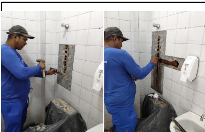
Figuras 03 e 04: Instalação de ponto d'agua na lanchonete de doadores.
