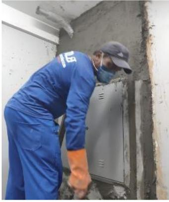
Figura 06: Execução de reboco na alvenária interna da sala de TI.
