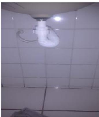
Figura 01: Troca do sifão localizado na pia do banheiro do segundo pavimento.
