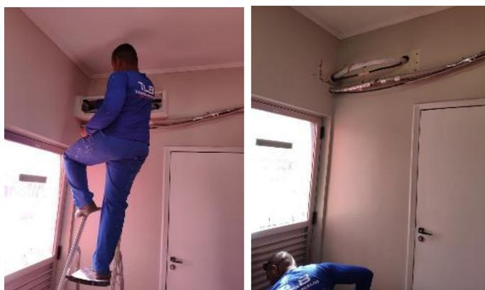
Figuras 02 e 03: Retirada de caixote de gesso acartonado presente na lancheonete de doadores.
