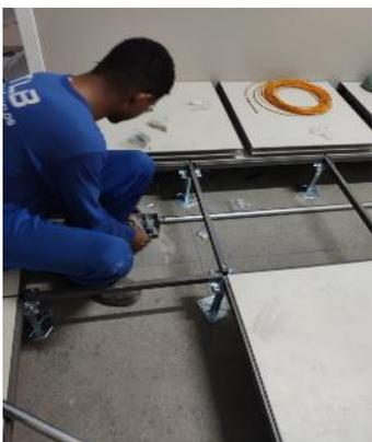
Figura 01: Instalação de tomadas no piso da sala de TI.
