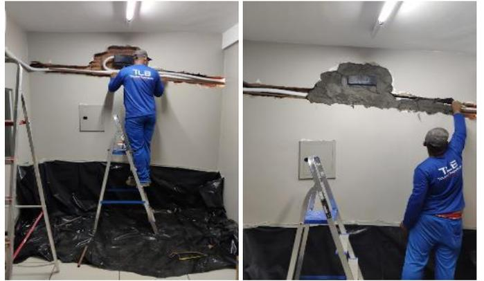
Figuras 06 e 07: Fixação de caixa auxiliadora de instalação do ar condicionado na sala de TI.
