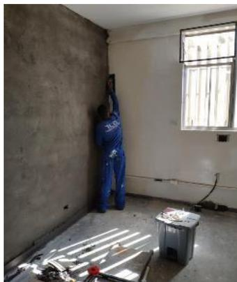
Figura 03: Emassamento com massa pva das paredes internas da sala em reforma.
