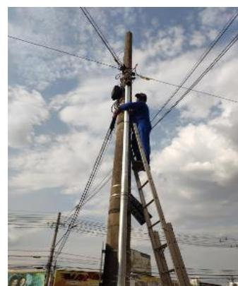
Figura 05: Instalação de cabeçote no eletroduto externo.
