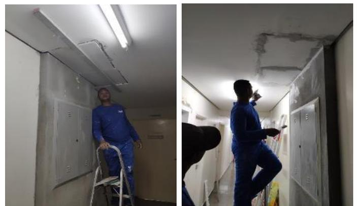
Figuras 04 e 05: Fechamento de vão presente no teto do corredor principal do segundo pavimento.
