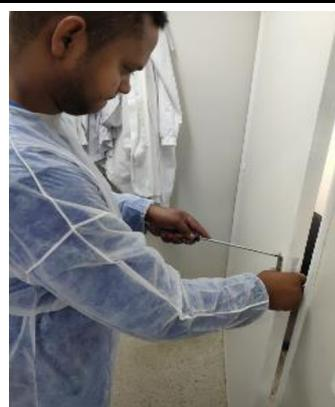
Figura 02: Reparo realizado na maçaneta e nos espelhos de fechadura da porta interna da sala de fracionamento.
