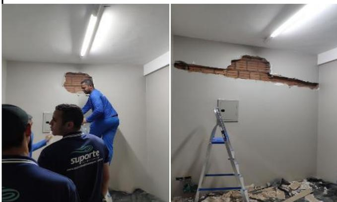
Figuras 03 e 04: Abertura de vão na alvenária para instalação do ar condicionado.
