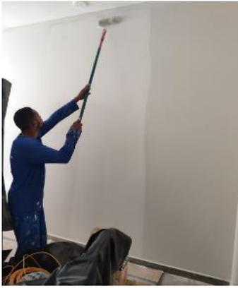
Figura 06: Aplicação da primeira demão de tinta na sala do CME.
