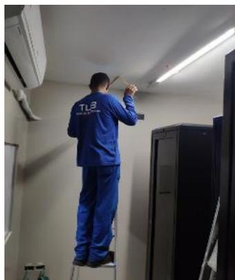
Figura 04: Marcação do layout das luminárias na sala de TI.
