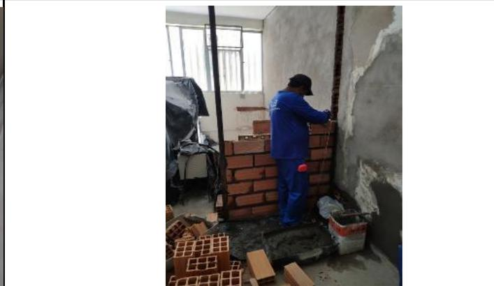
Figura 03: Execução de alvenária na sala de CME.
