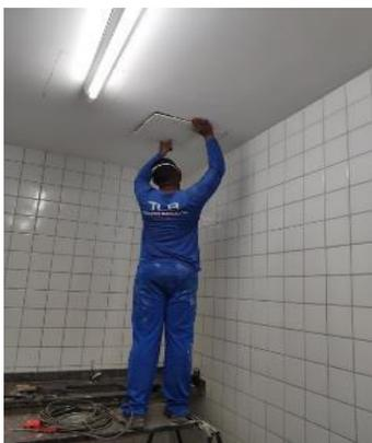
Figura 01: Fechamento de vão no teto utilizando placas de gesso no abrigo de residuos.
