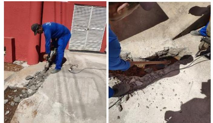
Figuras 02 e 03: Abertura realizada no concreto da calçada do abrigo de resíduos afim de sanar o vazamento d'água presente no local.
