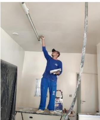
Figura 03: Emassamento com massa pva do teto.
