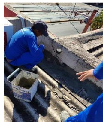
Figura 05: Manutenção e fixação dos rufos presentes no telhado.
