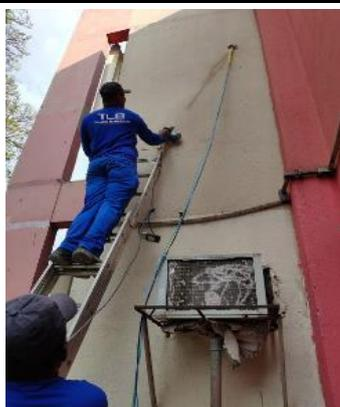
Figura 01: Corte na alvenária para passagem de fiação elétrica para alimentação do quadro elétrico da sala de TI.
