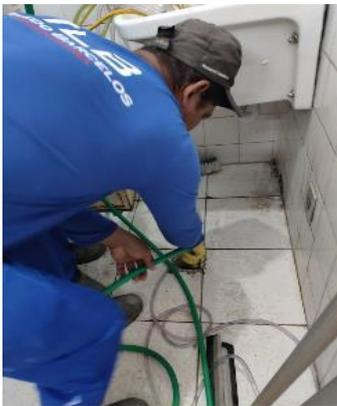
Figura 01: Desentupimento do ralo presente na área farmacêutica da unidade após contatação que o mesmo apresentava certo vazamento d'água constante.
