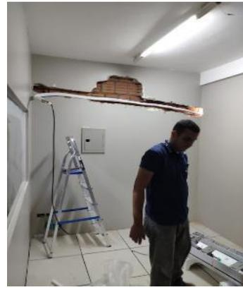
Figura 07: Passagem da tubulação utilizada na instalação do ar condicionado.
