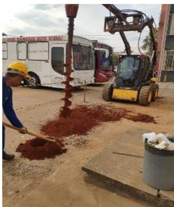
Figura 04: Acompanhamento da perfuração do solo para execução da concretagem de estacas escavadas.
