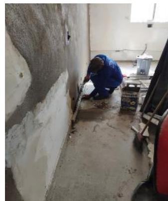
Figura 04: Execução de rodapé na sala em reforma.
