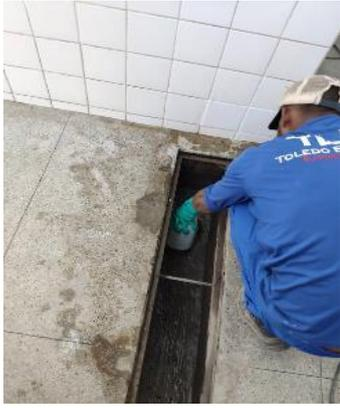
Figura 05: Desentupimento do ralo existente no abrigo de resíduos.
