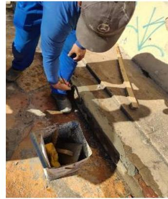
Figura 07: Reparo realizado na calçada externa do abrigo de resíduos.
