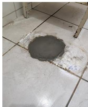
Figura 05: Isolamento de tubulação de esgoto localizada no abrigo de resíduos.
