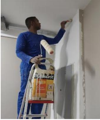
Figura 06: Realização de pintura na alvenária interna da sala de TI.
