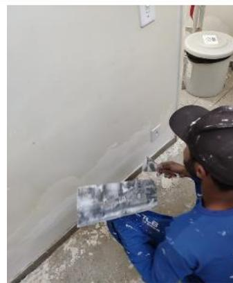
Figura 02: Aplicação de massa pva nas paredes e no teto.
