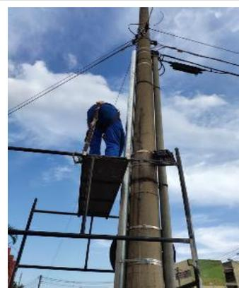
Figura 03: Término da instalação dos eletrodutos utilizados para passagem da rede lógica;
