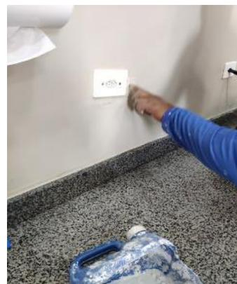
Figura 03: Requadros realizados na pintura da lancheonete de doadores utilizando gesso.
