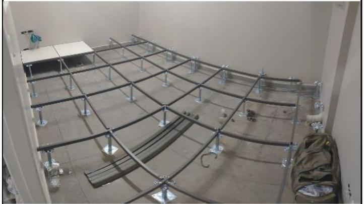
Figura 07: Acompanhamento da instalação do piso elevado na sala de TI.
