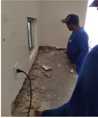
Figura 06: Remoção da bancada presente na sala do CME.
