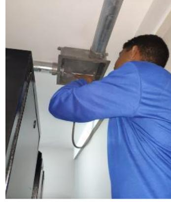
Figura 06: Passagem de fiação nos eletrodutos presentes na sala de TI.
