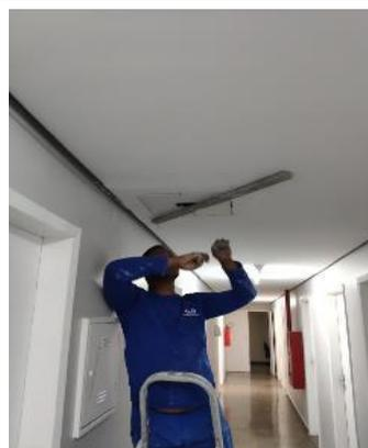
Figura 02: Fechamento de vão no teto do corredor utilizando placas de gesso.
