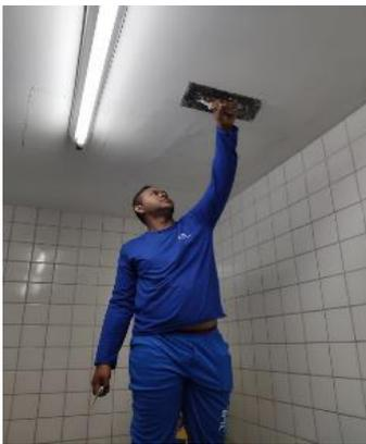
Figura 01: Emassamento com massa pva do teto do abrigo de resíduos.
