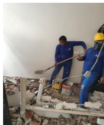
Figura 02: Limpeza do local envolvendo a retirada de entulho.
